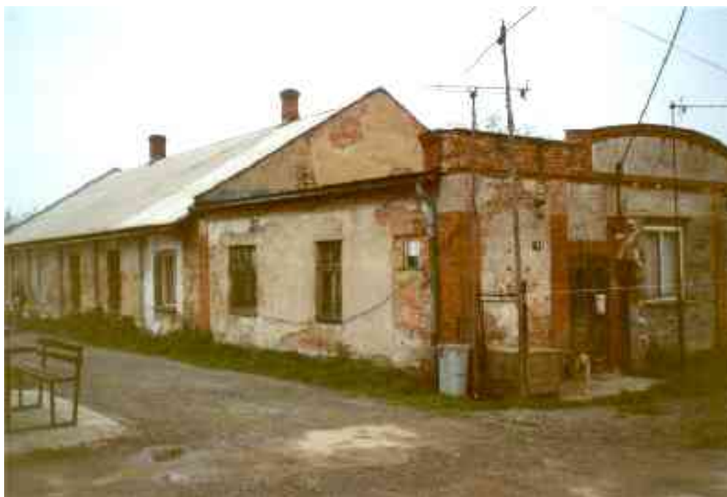
Objekt „Na Dolině“
