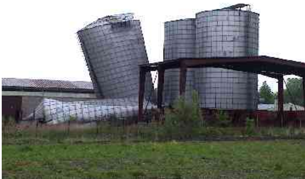
Demolice silážních věží
